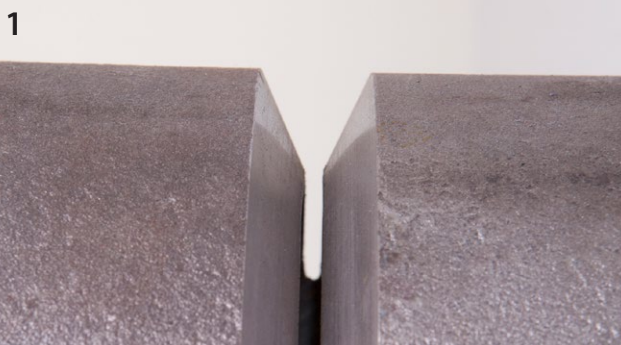
Nahtvorbereitung einer Wurzelschweißung am Rohr, 60° Öffnungswinkel mit 3 mm Luftspalt
